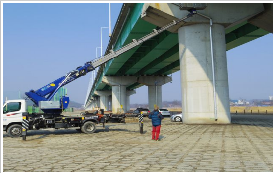
고소차를 이용한 외관조사
